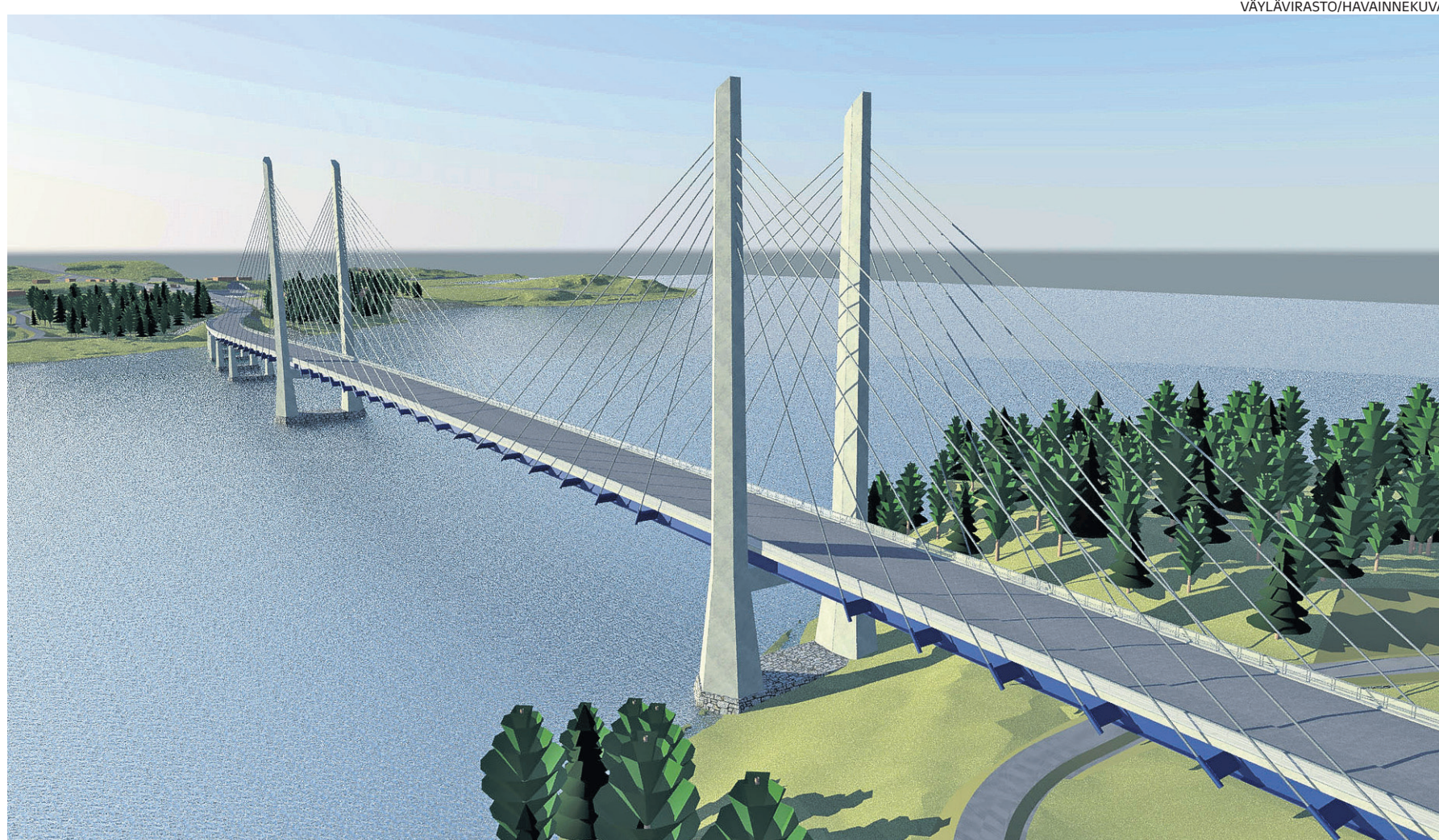
Kirjalansalmen silta pitenee hankkeessa peräti 313 metriä. Paraisten puoli on tarkoitus toteuttaa liittopalkkisiltana ja Kuusiston puolen pääaukko vinoköydisiltana.
