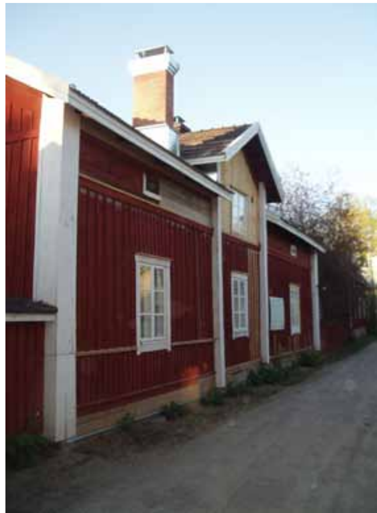
Björkfeldtin talon julkisivu korjattiin paikkaamalla.
