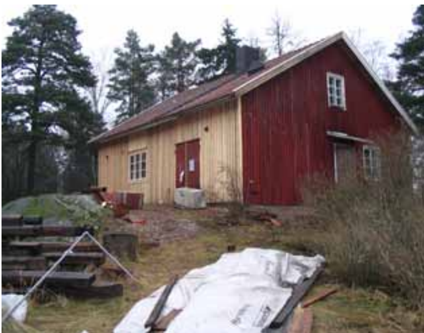
Leivintuvan ulkolaudoitusta hirsikorjausten jälkeen punamultaa odottaessa.
