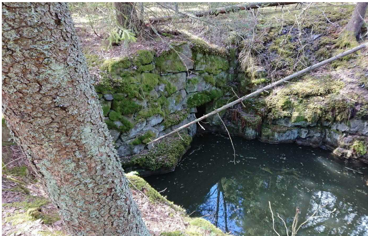
Kaivoksissa saattaa olla säilyneinä jopa kuilujen suuaukkojen tueksi tehtyjä rakenteita, kuten Perniön Vihiniemen rautakaivoksella. Kuva: Tanja Ratilainen, 2020, Turun museokeskus.
