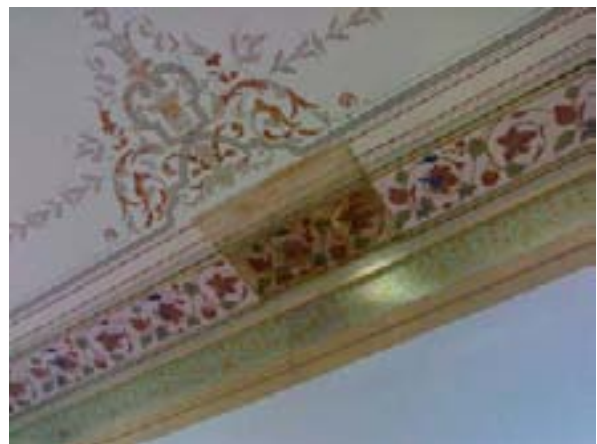
Kaupungintalon kattomaalauksen restaurointi. Kuva: Anna-Leena Seppälä
