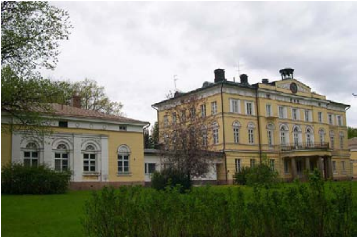
Vuojoen kartanon päärakennusta ja itäistä flyygeä yhdisti 1960-luvulla rakennettu nivelosa, joka sopi huonosti arvokkaaseen kartanomiljööseen. Restauraation yhteydessä osa poistettiin ja toiminnot siirrettiin maan alle.
