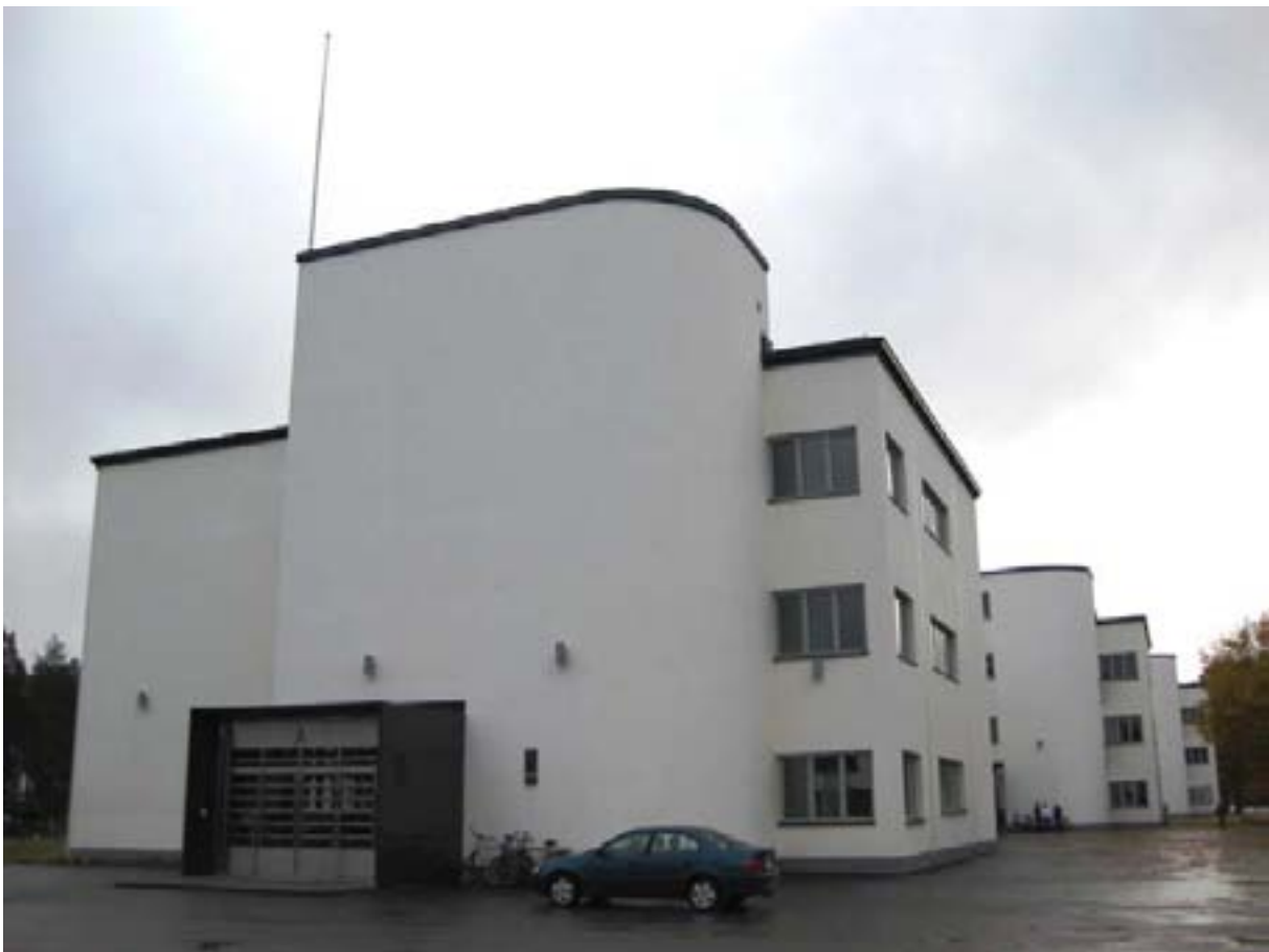
Niinisalon varuskunnan lamellikasarmi edustaa korkeatasoista 1930-luvun arkkitehtuuria.
