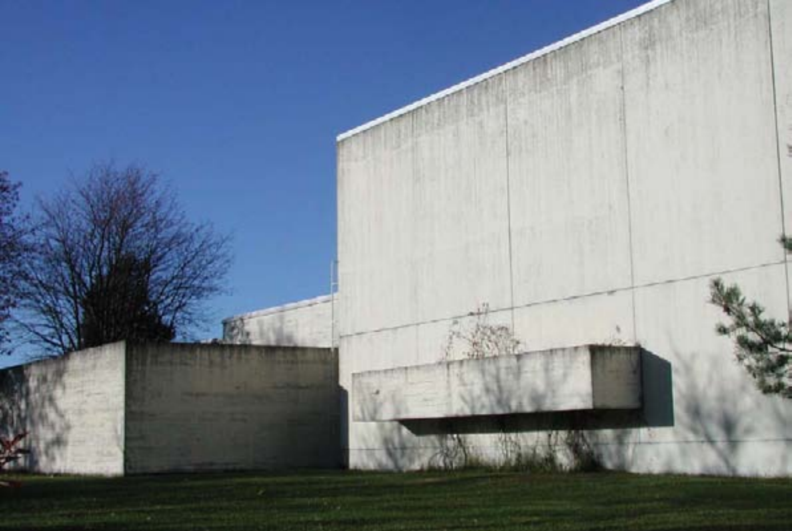
Pekka Pitkäsén suunnittelema Säskylän seurakuntakeskus edustaa 1960-luvun betonirakentamisen niukkaa estetiikkaa. Kuva: Lauri Putkonen
