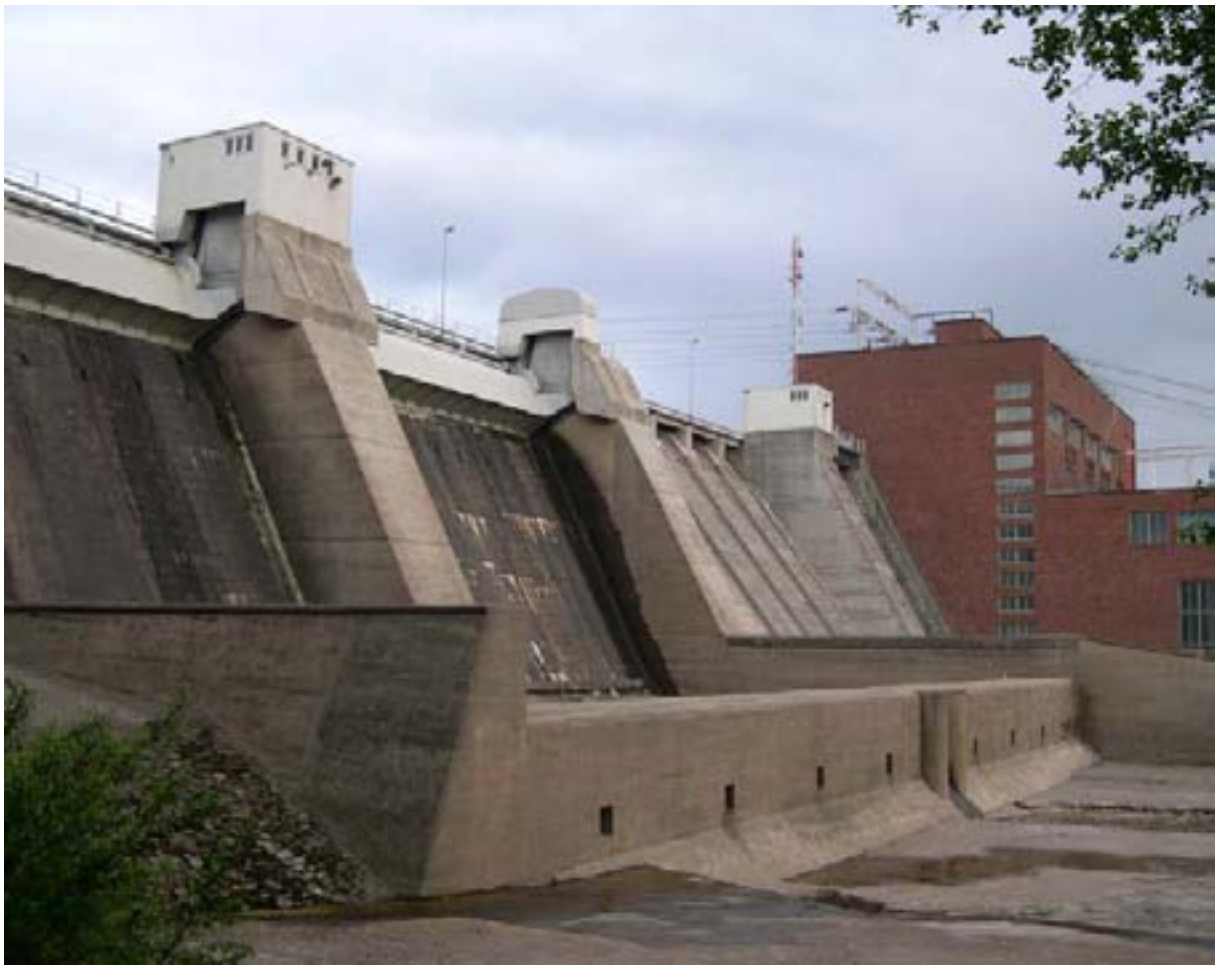
Erik Bryggmanin suunnittelema Harjavalan voimalaitos on valmistunut vuonna 1939.
