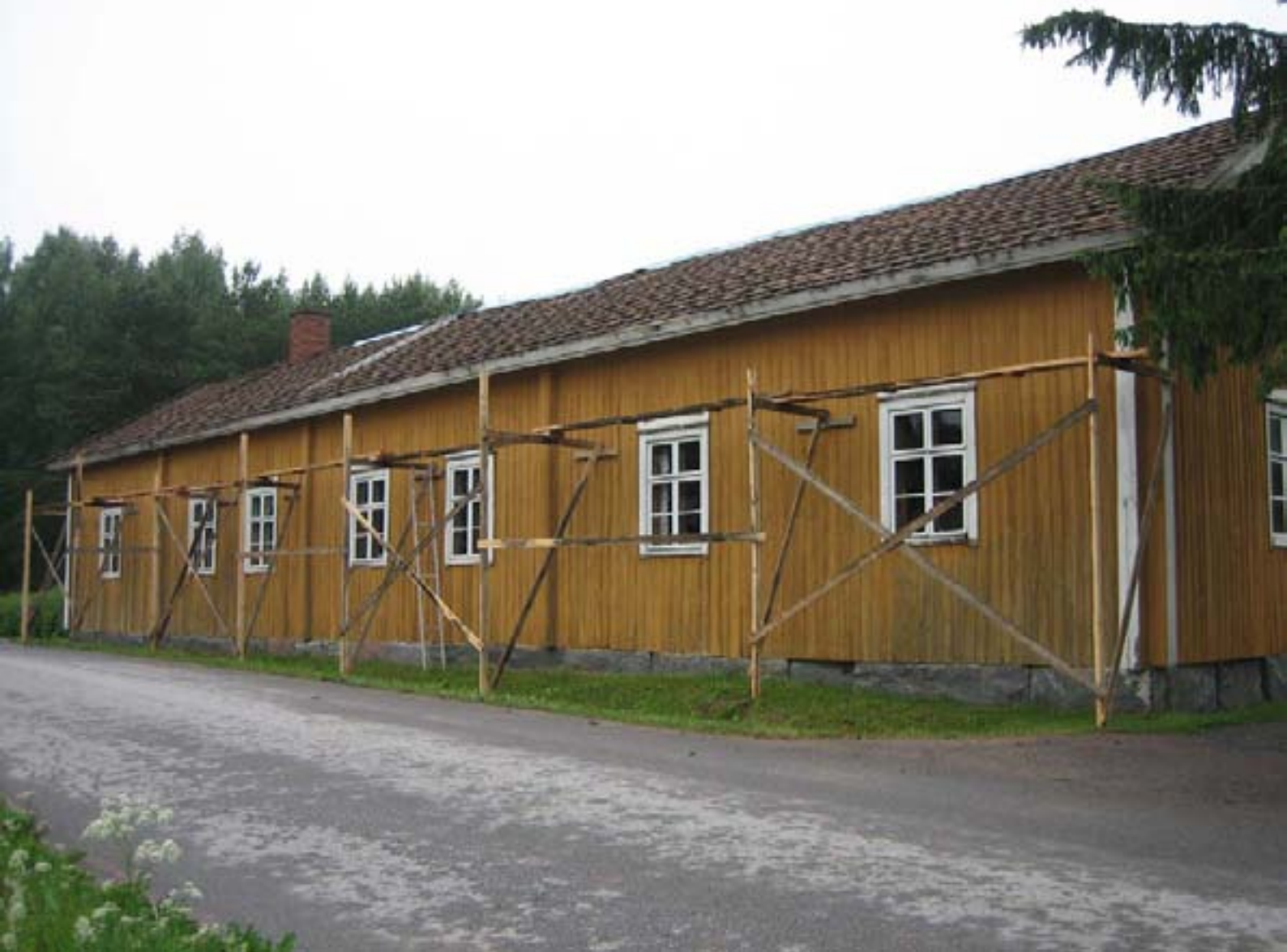
Hurrin talon kattoa korjataan. Kuva: Liisa Nummelin
