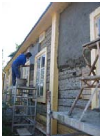
Vähälinnankatu 2:n työmaalla päästiin tekemään perinteistä savirappausta. Kuva: Tuulikki Kiilo
