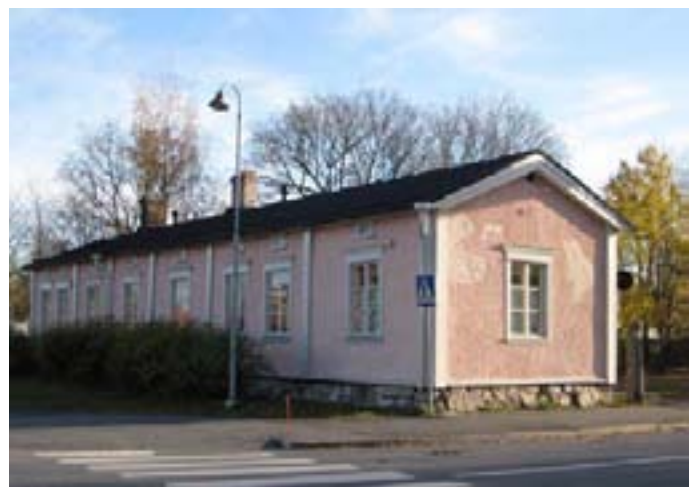
Vähälinnankatu 2:ssa sijaitseva Appelqvistin talo ennen kunnostusta ja sen jälkeen.
